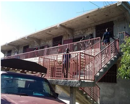
Dano - WIR bauen eine Schule.
