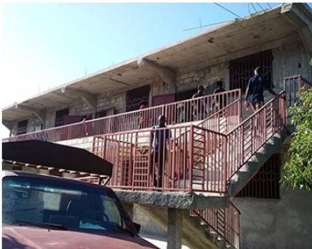
Dano - WIR bauen eine Schule
